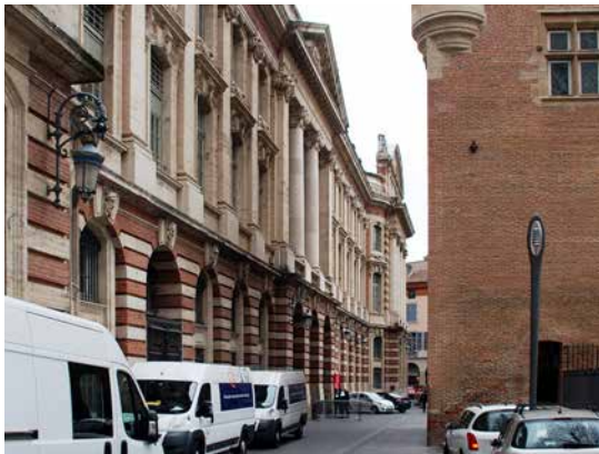
La rue Ernest Roschach entre le palais du Capitole et la tour des archives ou Donjon du Capitole, aujourd'hui Office du tourisme.
