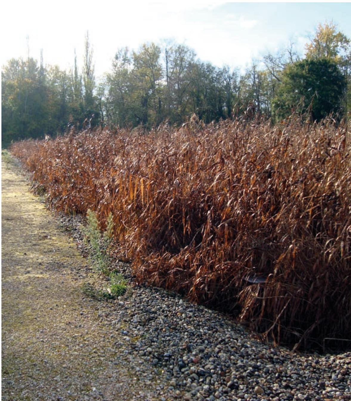
demande en ratio énergétique, avec le traitement des boues, environ 1 KWH/m<sup>3</sup> d'effluent soit 10 fois plus ; pour mémoire les roseaux traitent les boues : avantage considérable.
